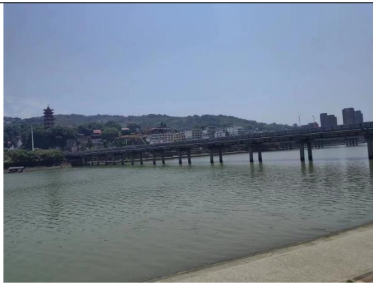
桥梁整体现状
