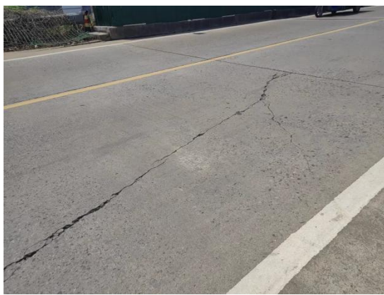
桥面裂缝
