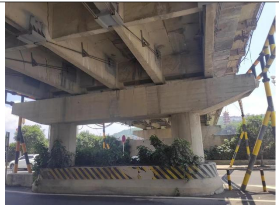
桥梁下部结构现状
